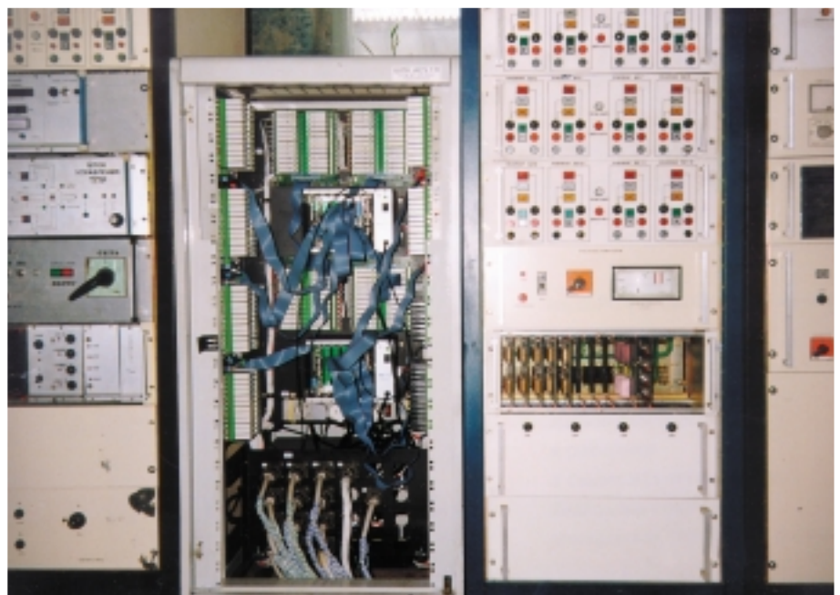
Рис. 9. Установка оборудования в шкафах
