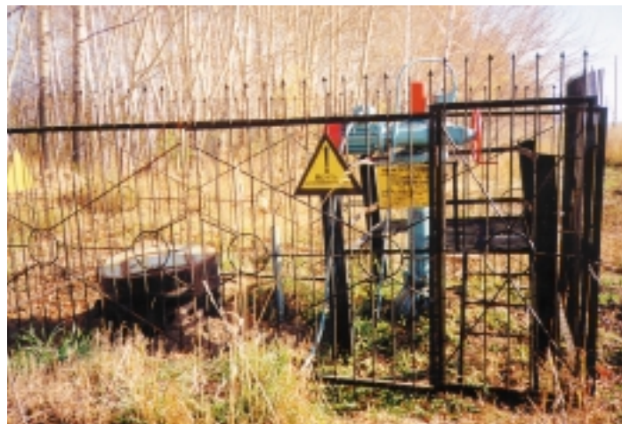
На трассе нефтепровода
